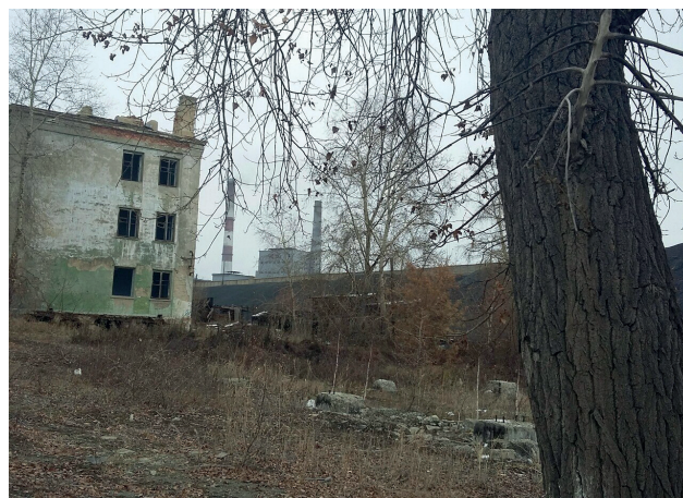
Рис. 2. Город Карабаш, Челябинская область, жилая застройка, попадающая в санитарно-защитную зону ЗАО «Карабашмедь»
